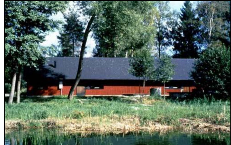
Ferric Chloride Treatment Unit at Lake Ronningsesjon, Taby Sweden (Karl Dunkers)
