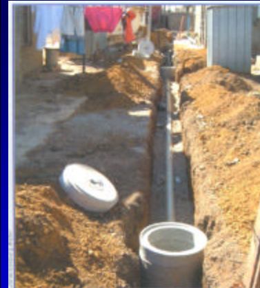
Installation de système d'assainissement condominial à Orange Farm. Set up of a condominium sewerage in Orange Farm.
