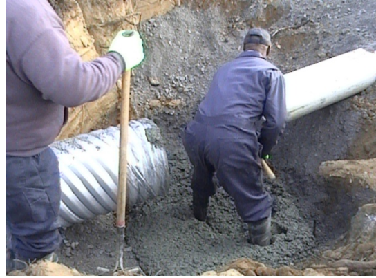
Concrete pour for the effluent chamber
