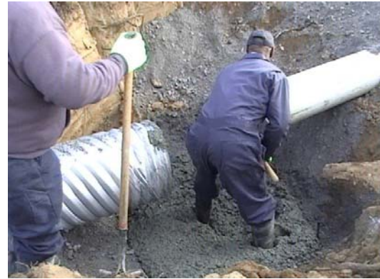
Concrete pour for the effluent chamber
